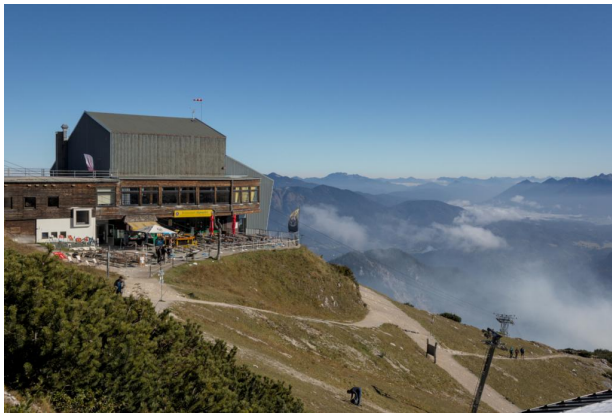
Abb. 3: Alpspitzbahn Bergstation - Quelle: Thomas (DO2TWE)
