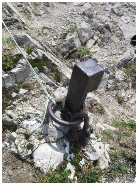
Abb. 2: Anker des Längstwellensenders von 1925
