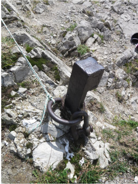
Abb. 2: Anker des Längstwellensenders von 1925 - Quelle: Sven (DG1SVE)
