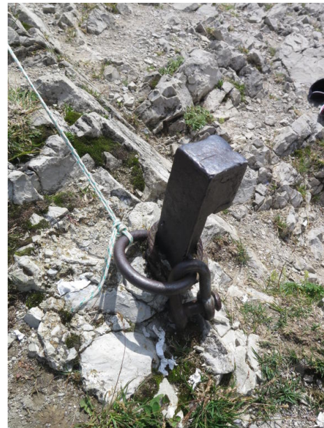
Abb. 2: Anker des Längstwellensenders von 1925
