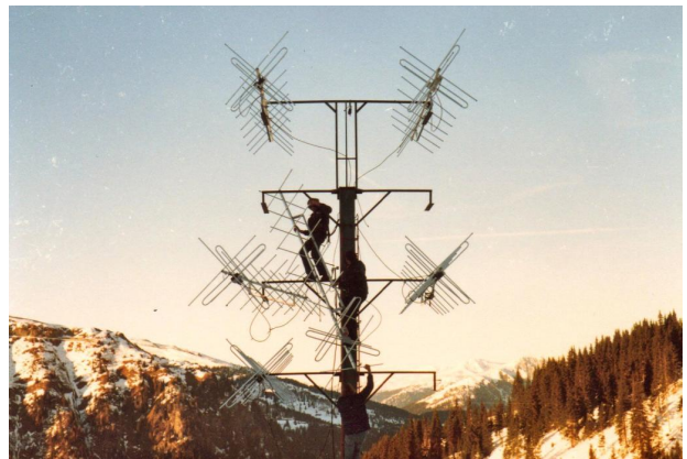
Abb. 3: Eine ehemalige Skilift-Stütze diente als Mast. Jede einzelne Antenne wurde von DG3WZ nicht nur montiert, sondern auch geplant und jedes Element eigenhändig gesägt und gebogen.
